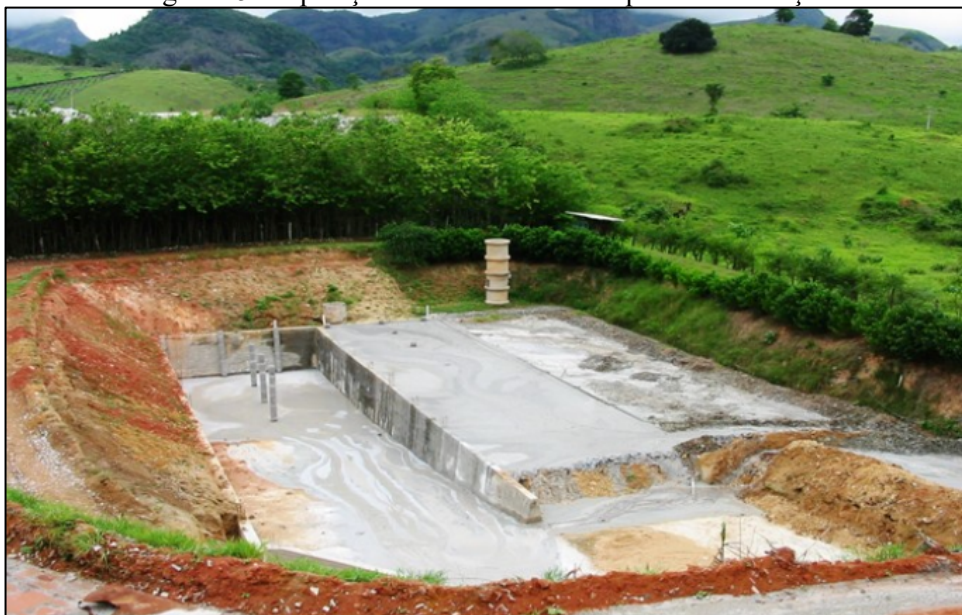
Figura 15. Deposição da LABRO em tanque de decantação.
